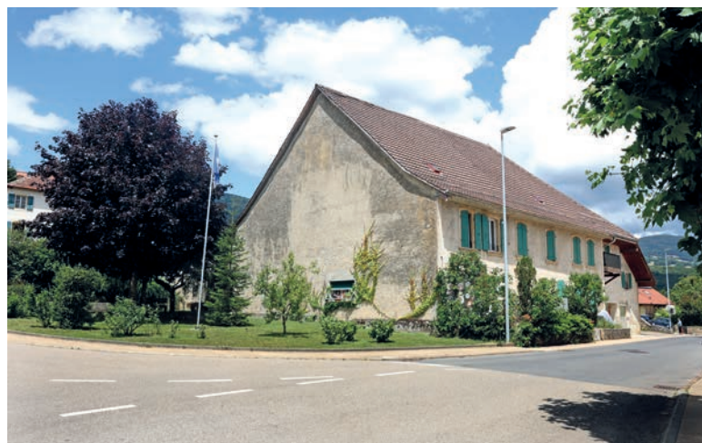
Le bâtiment situé à la route des Mûriers 1, à Fiez. C'est pour aménager une salle de travail sous les combles que la Fondation les Mûriers cherche 40 000 francs.
